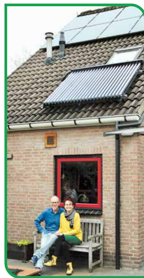
Harry en Kitty bij hun huis met zonnepanelen en systeem om warm water op te wekken.
