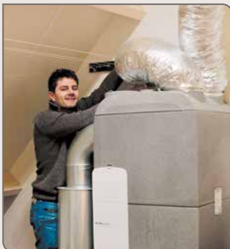
Michiel werkt aan de installatie van het balansventilatie-systeem in huis.
